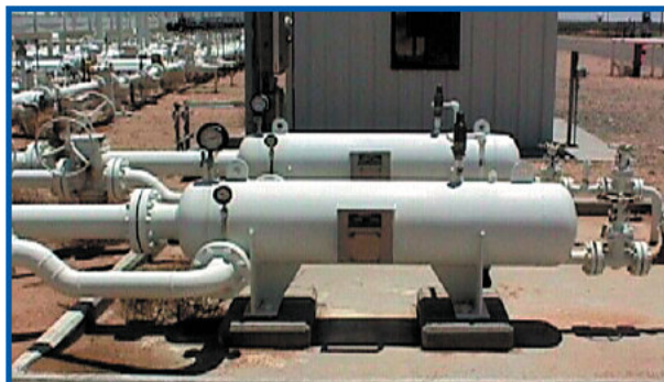
Zdjęcie powyżej: piaskownik typu DS firmy KREBS w typowej instalacji usuwania żwirów i innych zanieczyszczeń transportowanych wraz z gazem, olejem napędowym czy paliwem lotniczym
